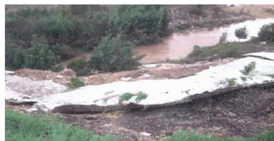
Otro tipo de problemática solucionada en la zona, está relacionada con los daños producidos por socavación y escorrentía superficial, que aceleraron el proceso de falla comprometiendo la funcionalidad del cuerpo de la presa.
